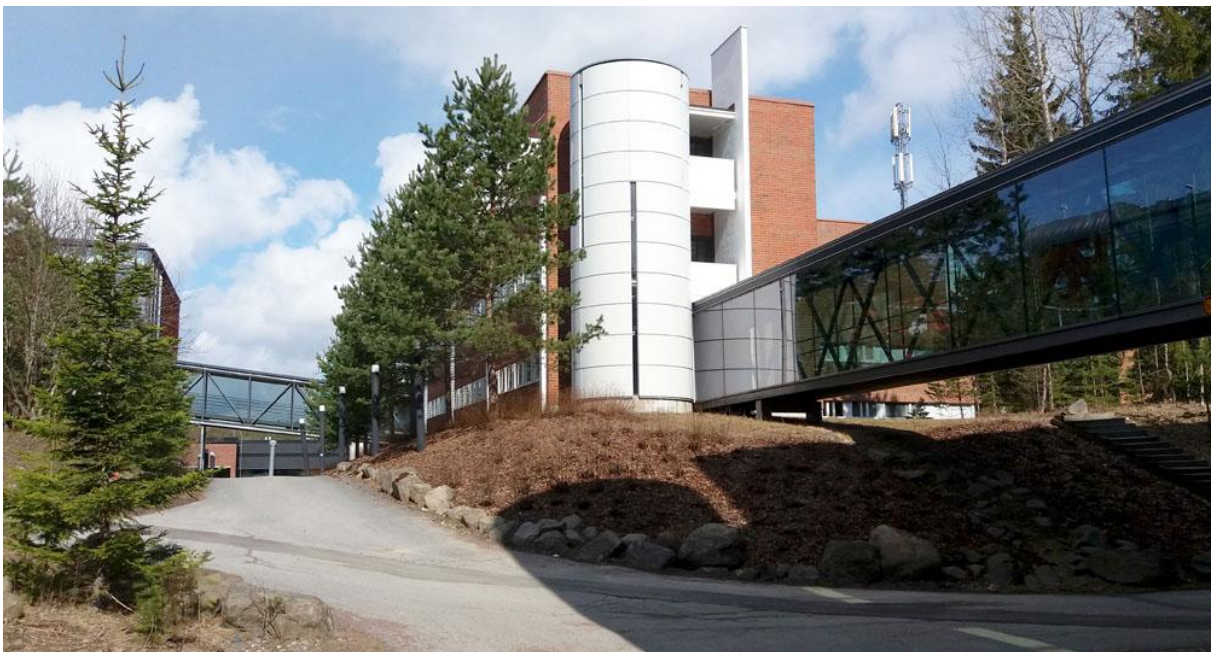
Kuva 18. Neljäs rakennusvaihe on yhdistetty lasikäytävin 6:nteen ja 7:nteen vaiheeseen.
