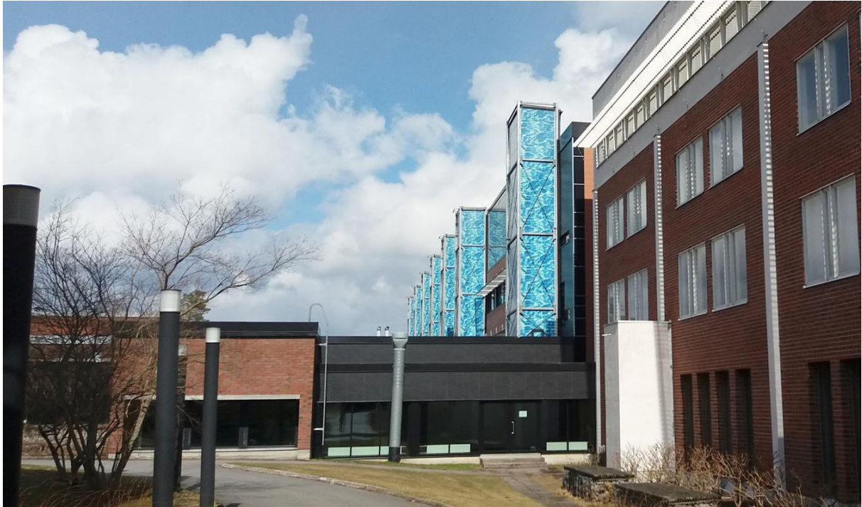
Kuva 17. Oikealla 4. rakennusvaiheen länsijulkisivua. Suoraan edessä näkyy 2. ja 3. rakennusvaiheen yhtymäkohta. Taustalla olevissa torneissa on 2. rakennusvaiheen talotekniikkaa (ilmanvaihto, vesi ym.).
