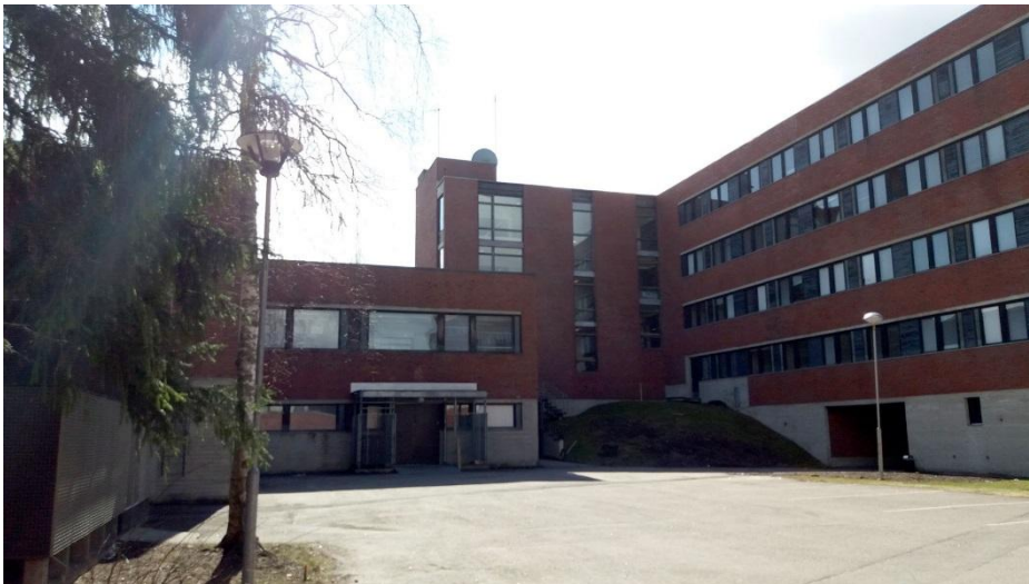
Kuva 16. 2. rakennusvaiheen julkisivu itään.
