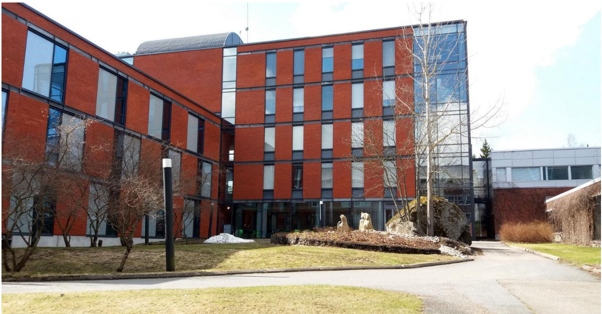
Kuva 20. 6. rakennusvaihe sisäpihalta päin.
